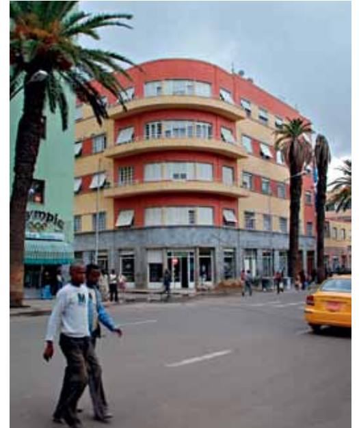
Moderne Infrastruktur: Asmara.
