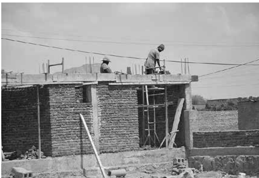
Der Bau des Zentrums kommt zügig voran
