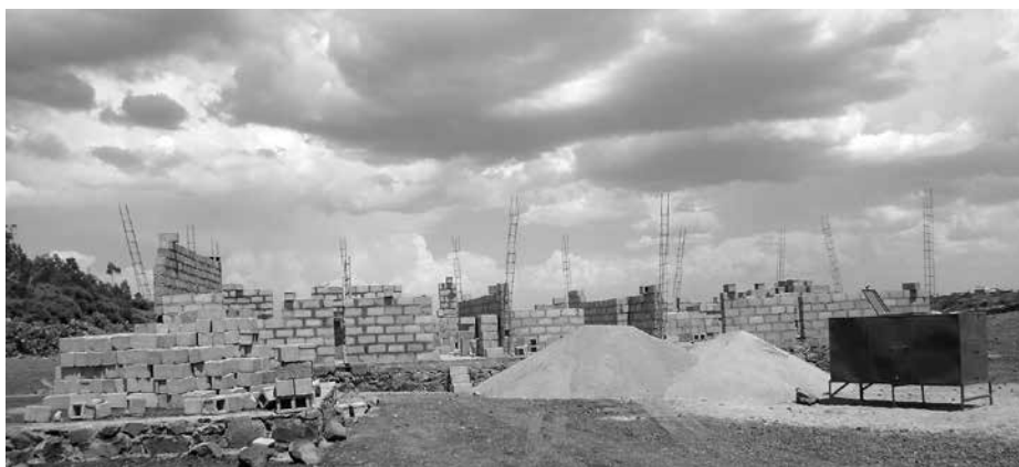
Baustand vor vier Monaten (Bild: EHD)
