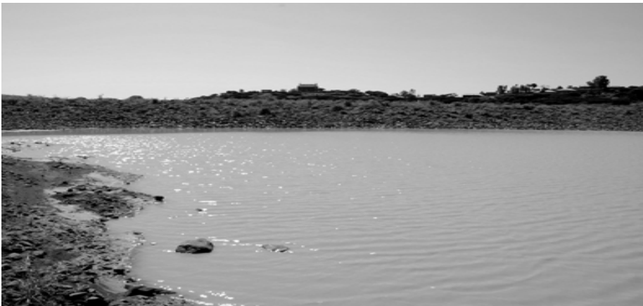
Hinter dem Damm staut sich das Regenwasser (Bild: EHD)
